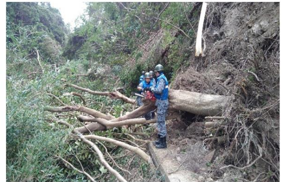
防災行政無線の仮復旧に向けた作業（富浦町深名）
