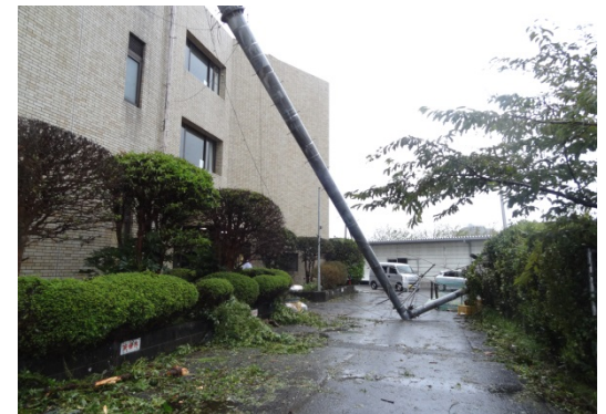
本庁舎屋上パンザマスト
