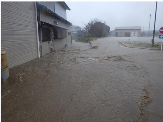
10月25日大雨による冠水（千倉七浦体育館入口）
