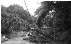
倒木により電線断線
