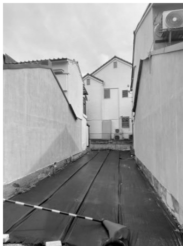
写真3 長屋の一部分のみを切り離して解体された例
